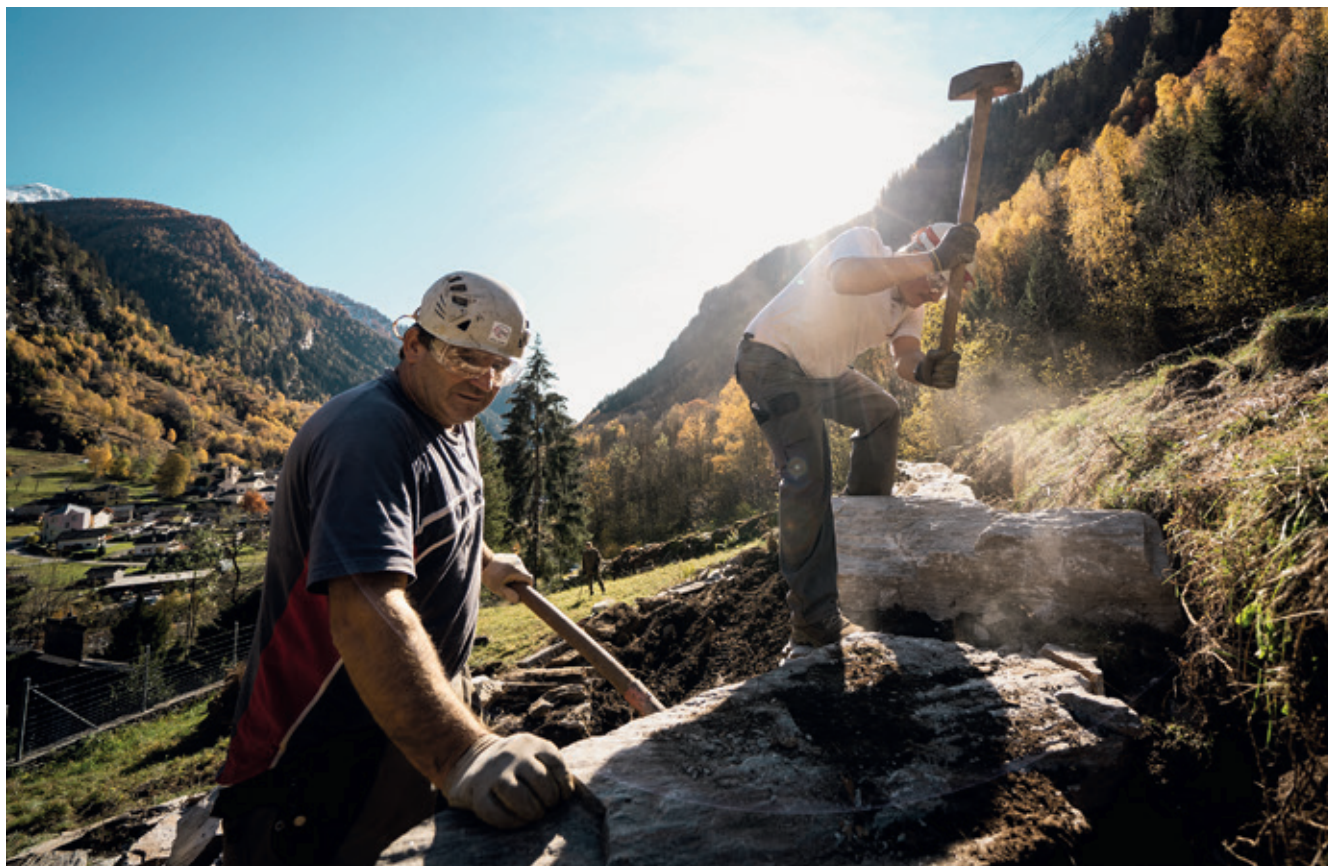
Réfection de murs en pierres sèches dans le Parco Val Calanca (candidat).
